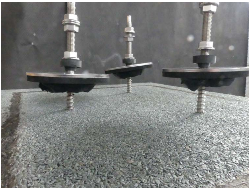
Bild 4: Dichtteller nach Auftrag der Dichtmasse vor dem Anziehen der Schrauben
