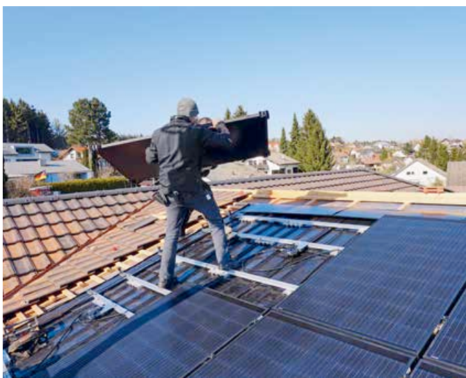
▲ Im nächsten Arbeitsschritt wurden die PV-Module montiert
