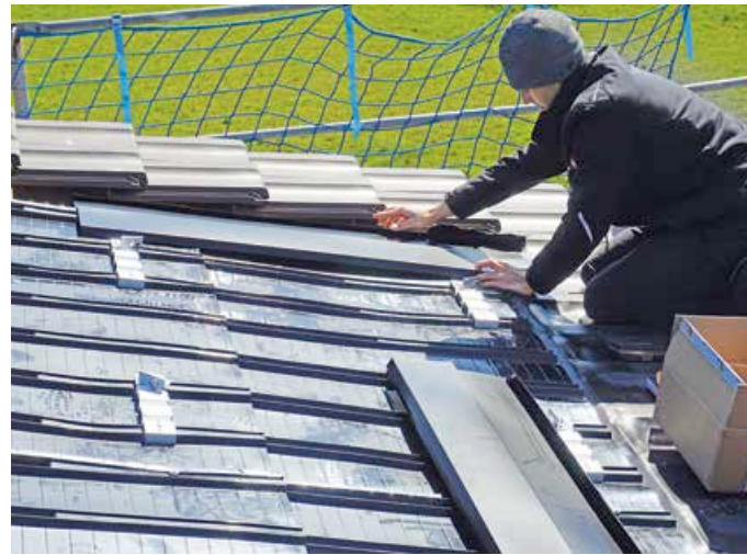
▲ Sauber integriert: An den Seiten kamen Anschlussbleche zum Einsatz
