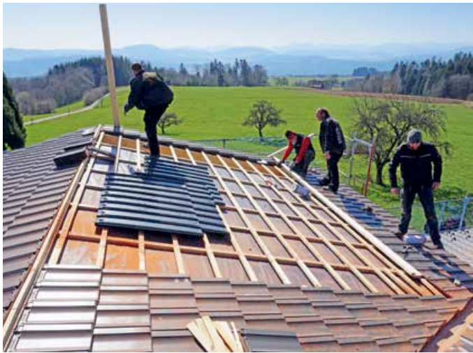
▲ Solide Unterkonstruktion: Zunächst wird die Intersole ausgelegt
