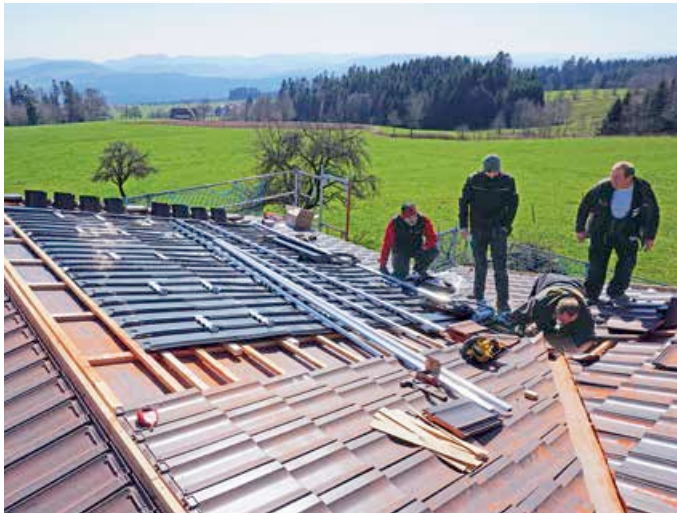
▲ Nachdem die Anker gesetzt waren, wurden die Schienen montiert
