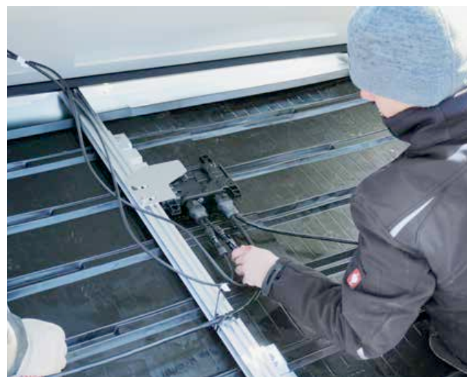
▲ Zuvor galt es, jedes Modul an einen Mikro-Wechselrichter anzuschließen
