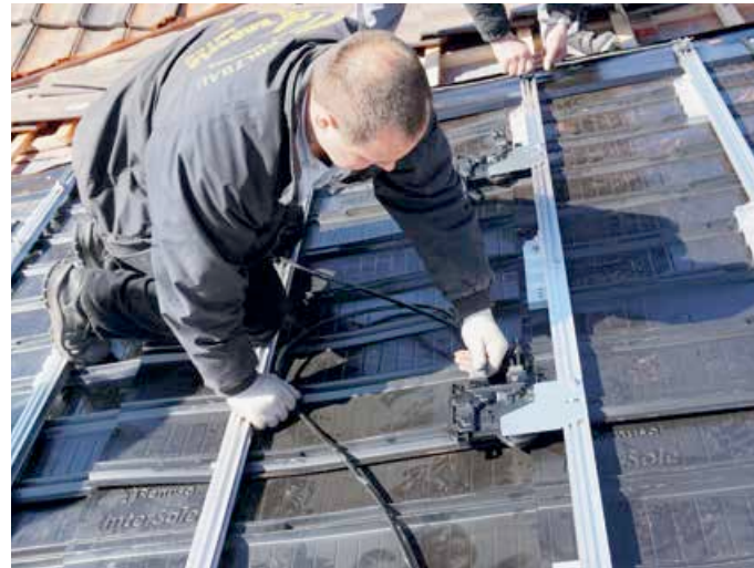
▲ Einfache Sache: Montage und Verkabelung der Mikro-Wechselrichter
