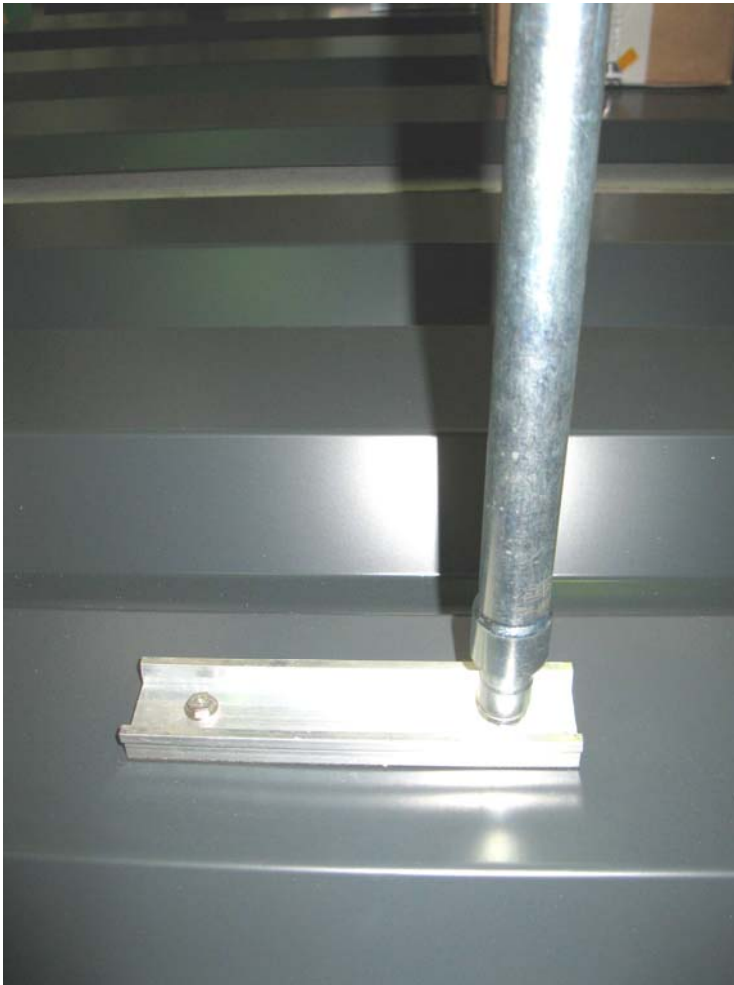
Bild 5: Anziehen der SFS-Bohrschraube mit dem speziell dafür vor- gesehenen SFS-Aufsatz
