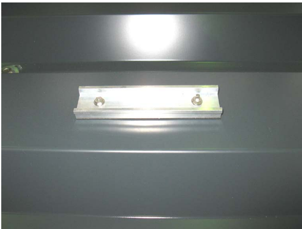
Bild 4: Auf dem Trapezblech mit SFS-Bohrschrauben befestigter Klemmfuß links: bereits abgedrehter Schraubenkopfaufsatz
